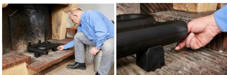
Introduisez l'embout lisse de la gaine dans la tubulure du serpentin.
