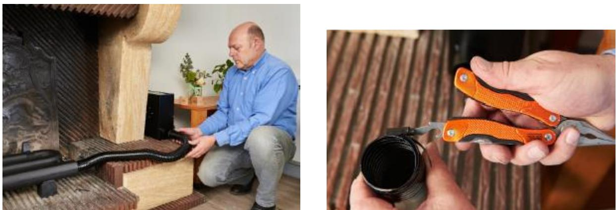
L'embout de la gaine flexible vient s'emboiter dans la sortie du ventilateur.
